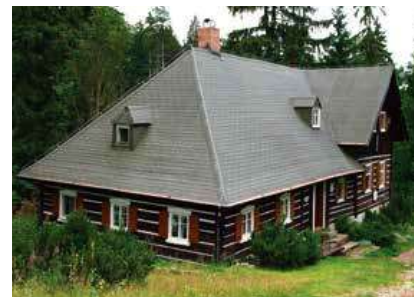
Tak vypadal Kristiánov před rekonstrukcí. Stav je z roku 2008
