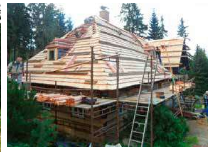
V červnu 2016 se na střechu pokládá tradiční štípaný šindel ze smrkového dřeva
