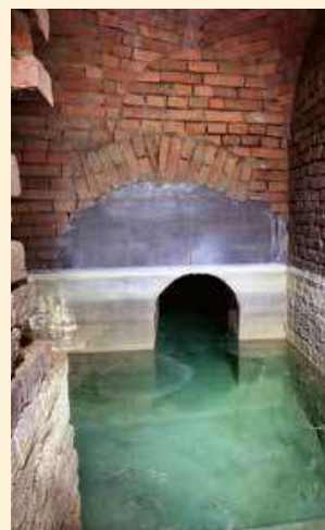
Adrenalinové znojemské podzemí
