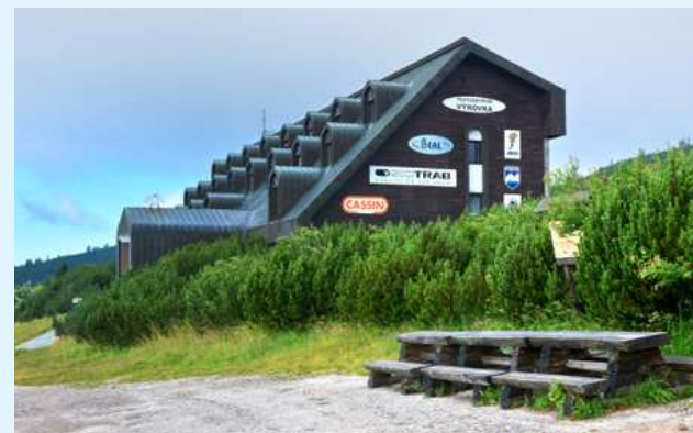
Boční pohled na štitovou stěnu Výrovky směrem od kapličky
