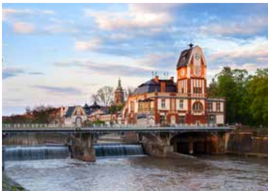
Vodní elektrárna Hučák v Hradci Králové (foto: archiv Skupiny ČEZ)
